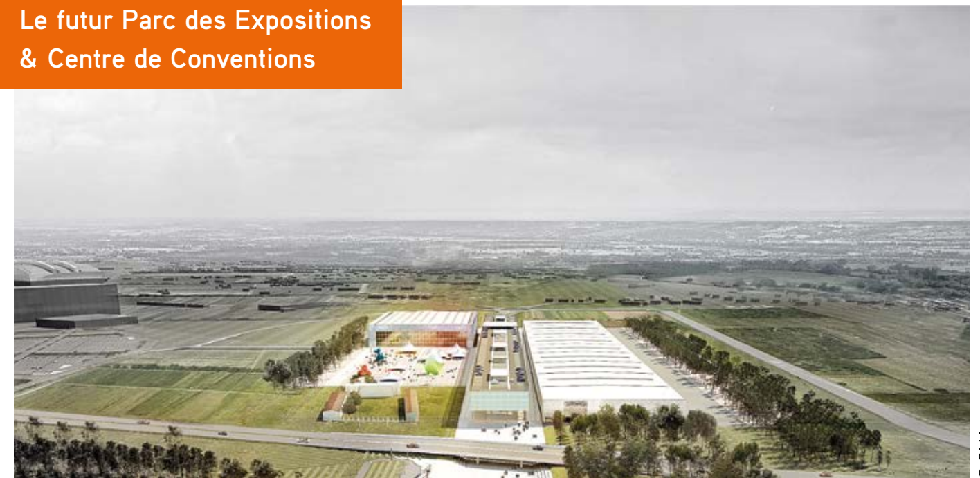
À gauche la Halle des Conventions – Au centre le parking silo au-dessus de la rue centrale et le parvis en-dessous du prolongement de la RD902 – À droite le Hall d'expositions
